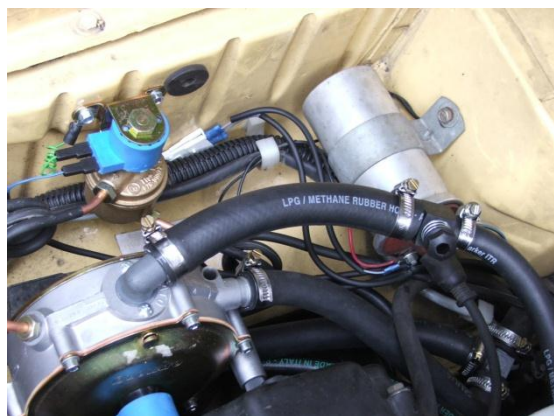
Slika 10: Pravilna montaža isparivača uz korišćenje odgovarajućih cevi za gas niskog pritiska i tečnost za grejanje ali i uz loš izbor mesta gde postaviti slavinu za protok gasa – neposredno iznad bobine:
